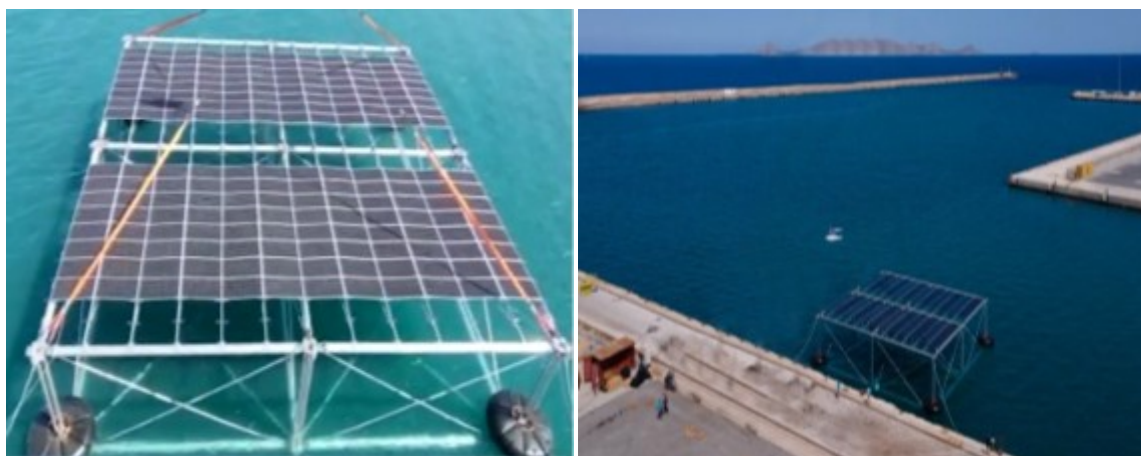
Εικόνα 87: Εφαρμογή υβριδικής φάρμας συνεκμετάλλευσης κυματικής ηλιακής ενέργειας στο λιμάνι του Ηρακλείου.
