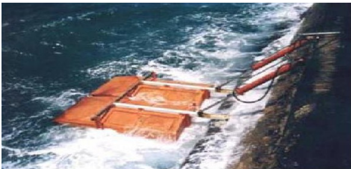
Εικόνα 65: Εγκατάσταση συστήματος SDE στο Ισραήλ.
