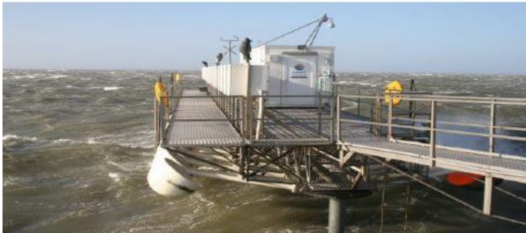
Εικόνα 68: Εγκατάσταση διάταξης WaveStar.
