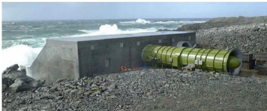
Εικόνα 57: Η εγκατάσταση LIMPET (Σκωτία).
