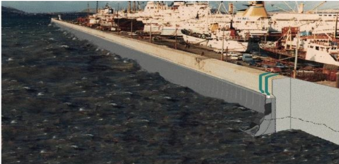
Εικόνα 60: Προτεινόμενη εφαρμογή μετατροπής κυματικής ενέργειας σε κυματοθραύστη WECA.
