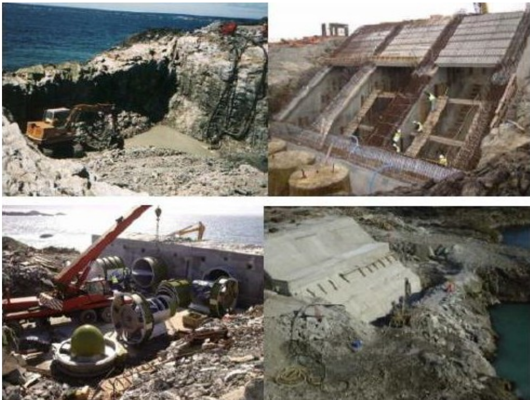
Εικόνα 59: Διαδικασίες – στάδια κατασκευής της διάταξης LIMPET.
