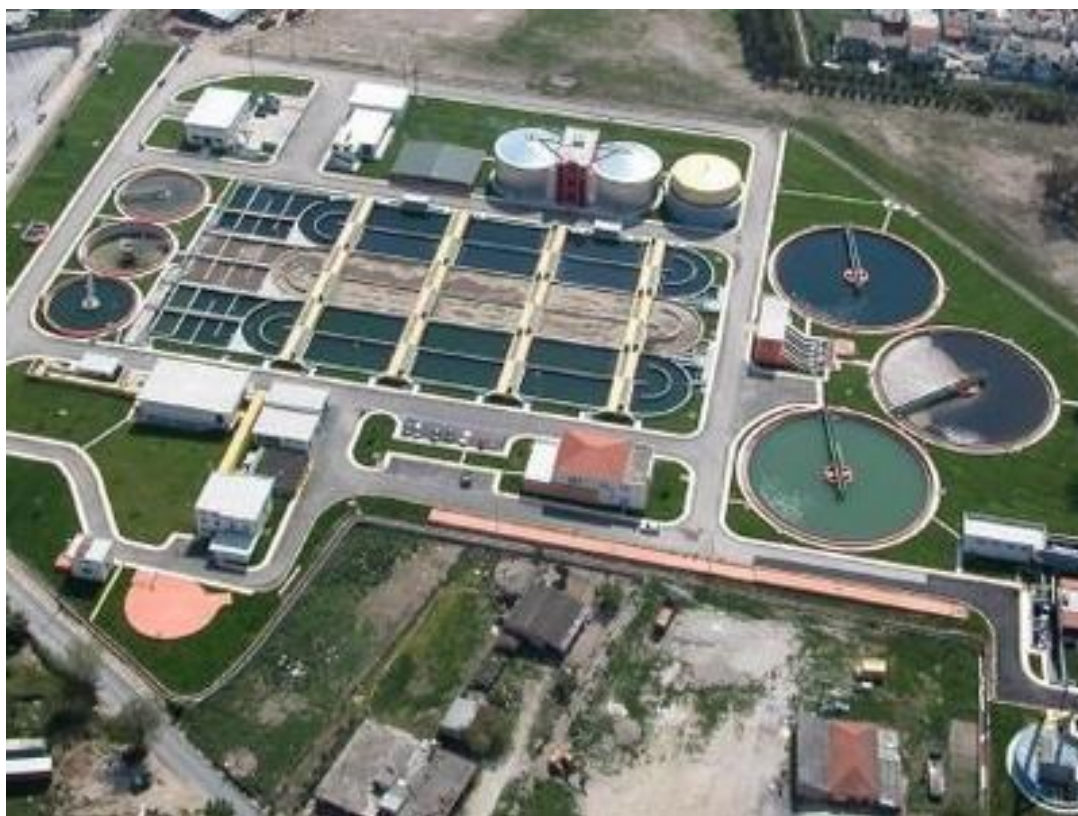
Εικόνα 14: Εγκαταστάσεις βιολογικού καθαρισμού Πάτρας (Διαδίκτυο).
