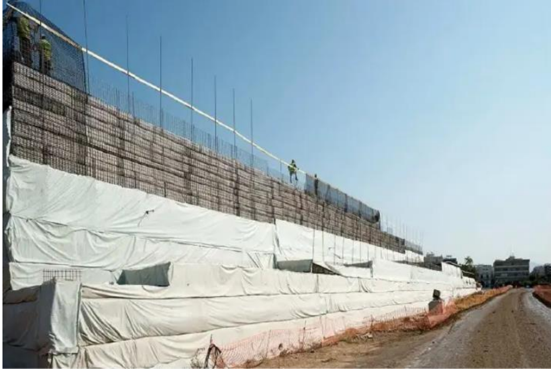
Εικόνα 6.7: Σχεδιασμός και κατασκευή του λόφου με βάση την μέθοδο των γεωπλεγμάτων της οπλισμένης γης
