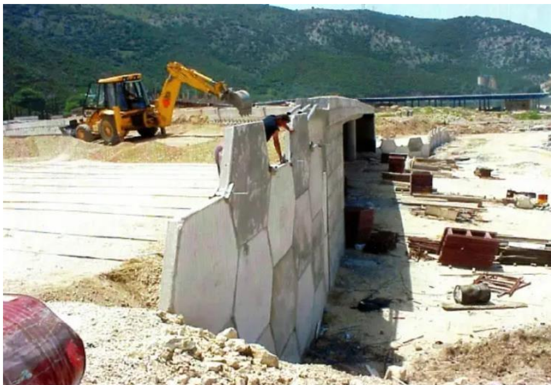
Εικόνα 6.5: Κατασκευή τοίχων οπλισμένης γης Εγνατίας οδού
