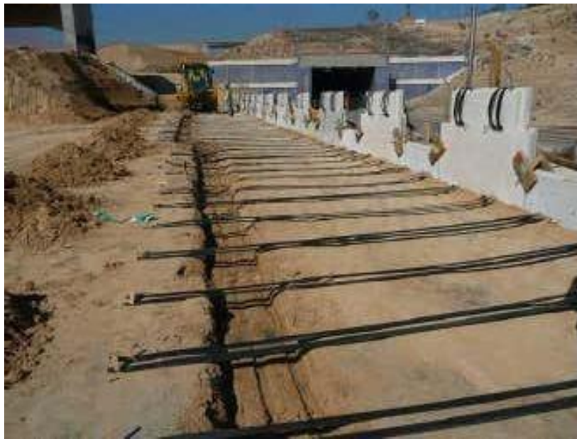
Εικόνα 5.3: Κατασκευή οπλισμένης γης
