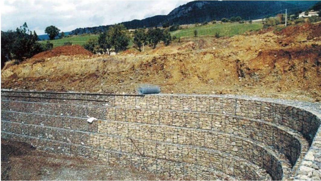
Εικόνα 6.10: Οπλισμένο επίχωμα με συρματοκιβώτια
