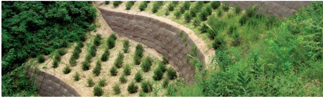
Εικόνα 8.2 Σύστημα Οπλισμένης γης [Green Terramesh]
