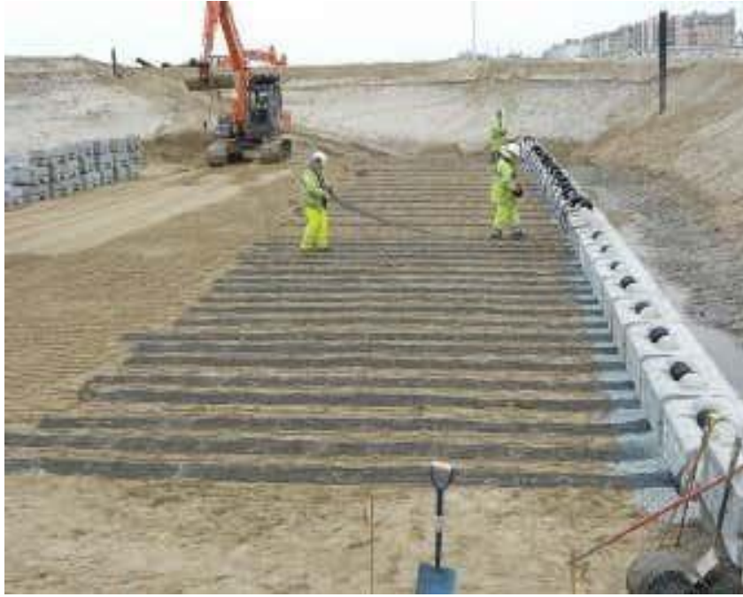
Εικόνα 5.2: Κατασκευή οπλισμένης γης
