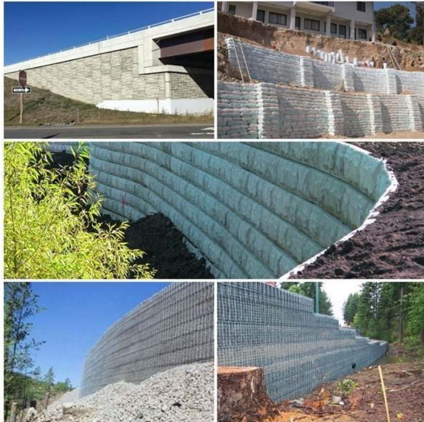
Εικόνα 6.3: Αντιστήριξη φυσικού εδάφους
