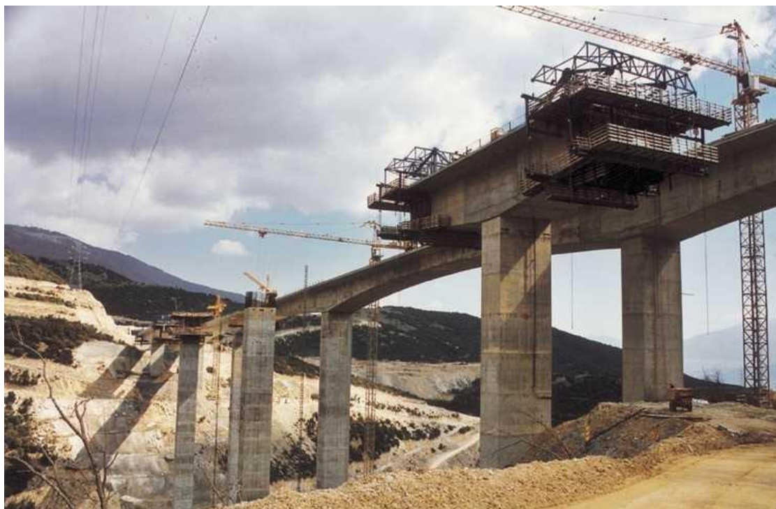
Εικόνα 6.4: Κατασκευή Εγνατίας οδού
