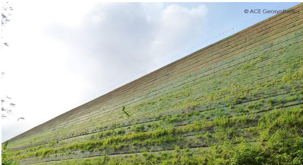
Εικόνα 6.9: Οπλισμένο επίχωμα με τεχνητή φύτευση
