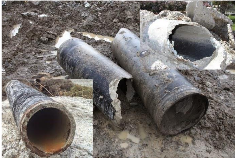
Εικόνα 15: Σωλήνα από αμιαντοσιμέντο [Διαδίκτυο 15]
