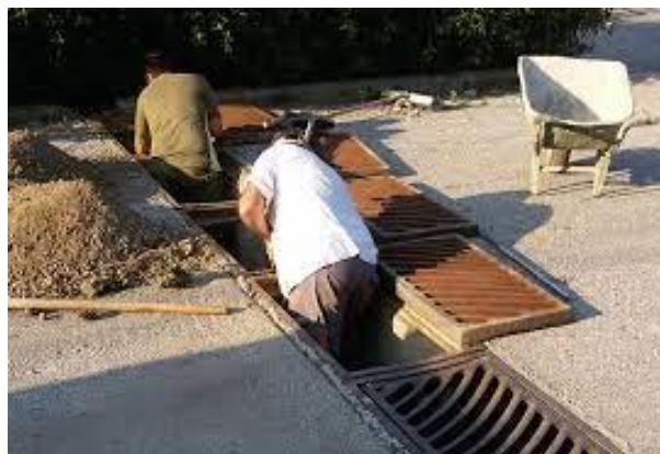
Εικόνα 6: Εργασίες ελέγχου και καθαρισμού σχαρών ομβρίων υδάτων και φρεατίων [Διαδίκτυο 6].
