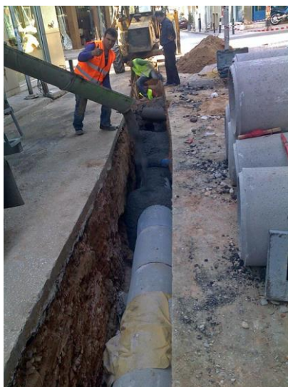
Εικόνα 7: Αποχέτευση ομβρίων υδάτων Δήμος Χαλανδρίου [Διαδίκτυο 7].
