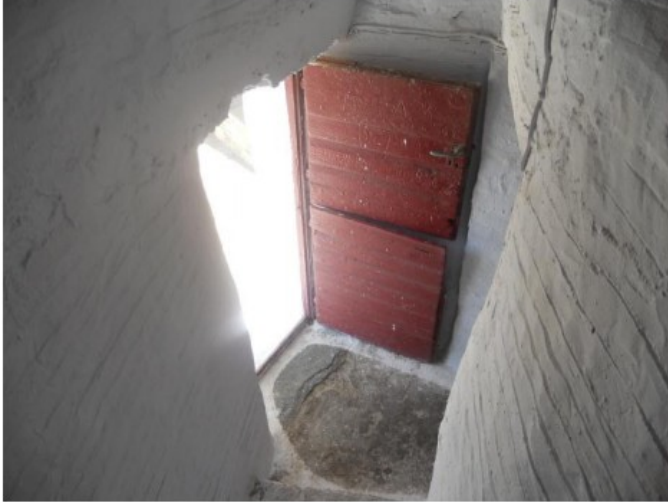
Εξωτερική και εσωτερική πόρτα του ανεμόμυλου στον «Κάκτο».
