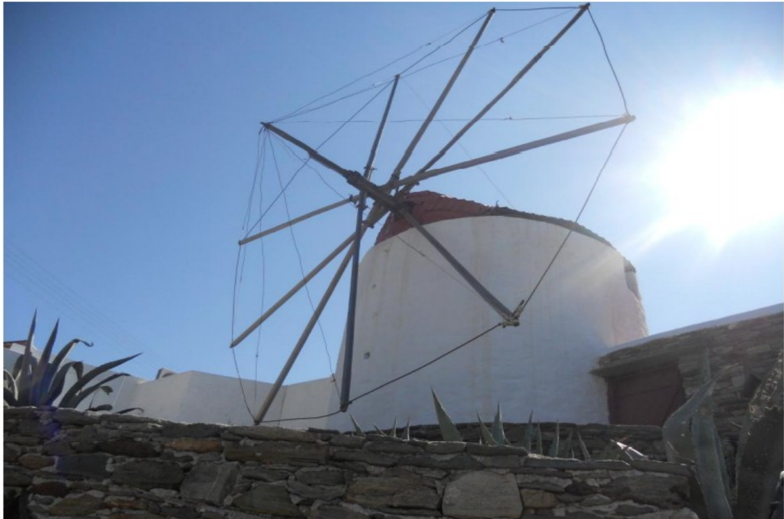
Οι αντένες και η κυκλική στεφάνη που συνδέει τα άκρα τους
