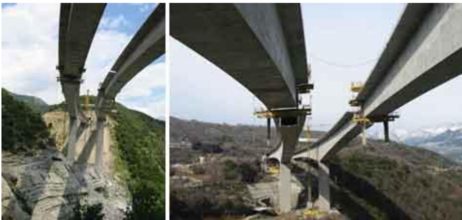
Εικόνα 1-1 Κοιλαδογέφυρα από σκυρόδεμα
